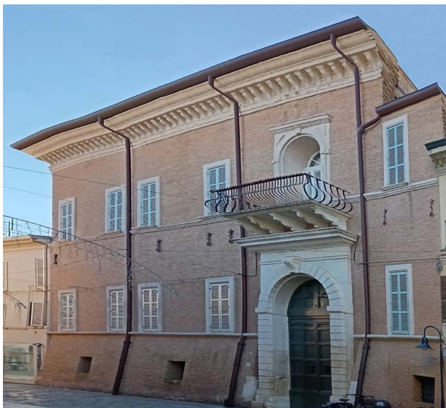
Facciata dopo i lavori di restauro del palazzo Guiccioli.
